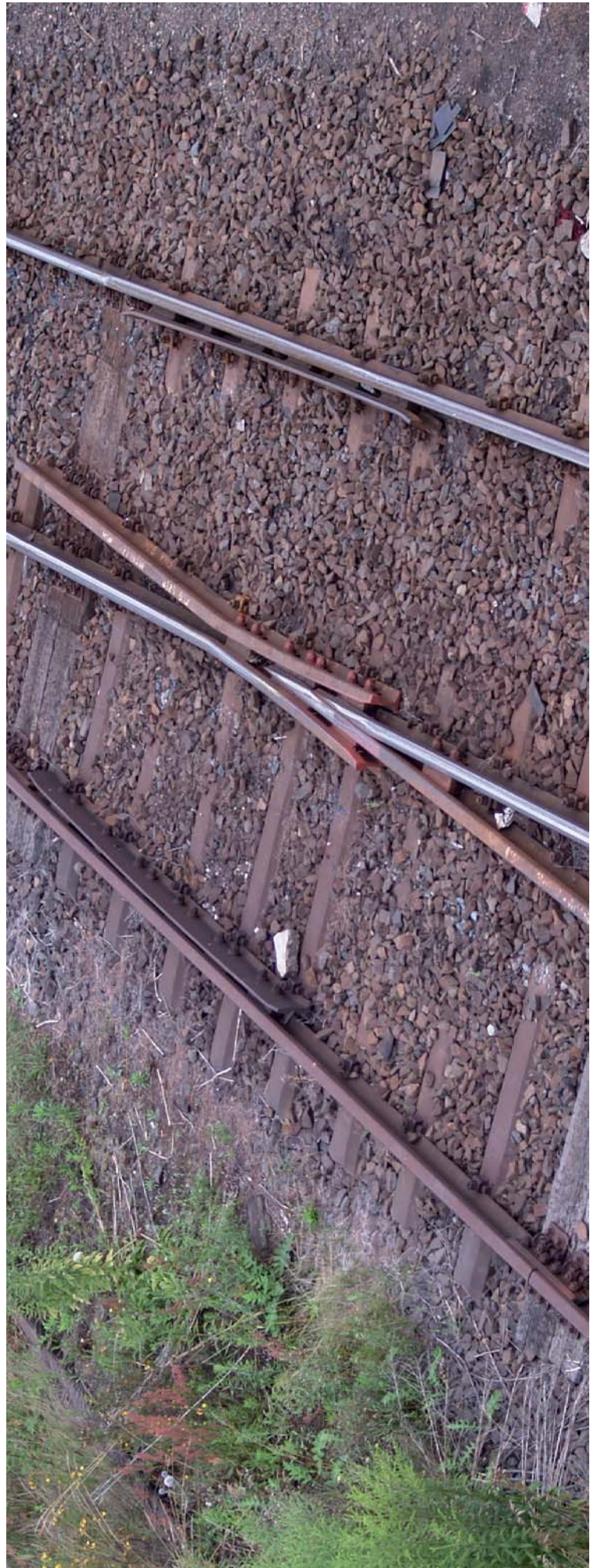
Anordnung der Radlenker an einer teiltrückgebauten Weiche in Halle/Saale Gbf
