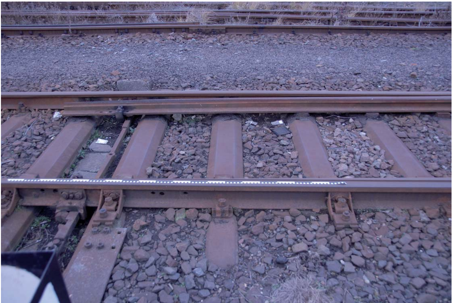
Zungenvorrichtung mit Klammerspitzenverschluß
